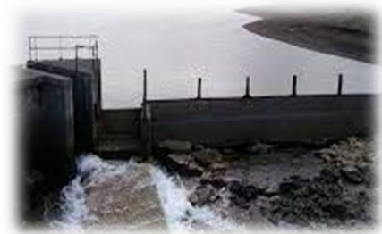
Mynd 2: Stíflan við Mjósund. Vinstra megin á myndinni sést op sem leyfir sjó að flæða inn í Hraunsfjörð á stórstraumslóði.
